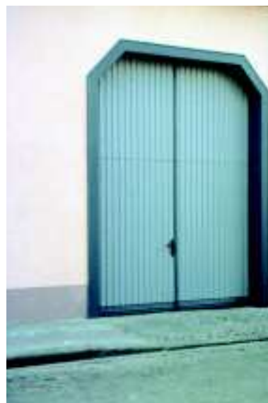
Abb. 143: Hoftorerneuerung in beispielhafter Weise
