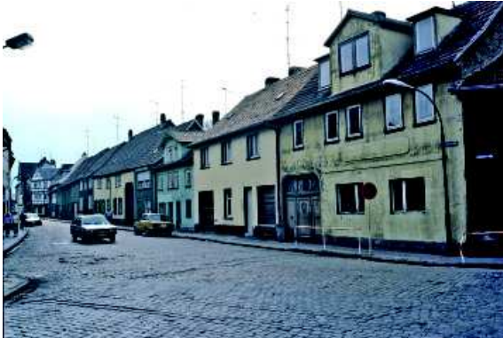
Abb. 21: Mischung von Gebäuden in der Langen Straße – Vorn Typ 1, Mitte Typ 2 und im Hintergrund Typ 3
