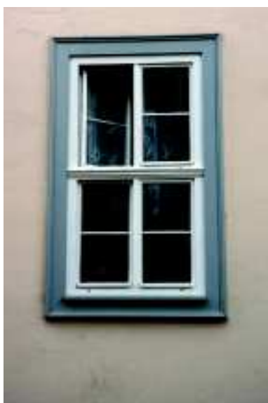
Abb. 130: Fenster sollten mit deckend weißen Rahmen und Flügelrahmen ausgeführt werden, die Bekleidungen sind farbig abzusetzen.
