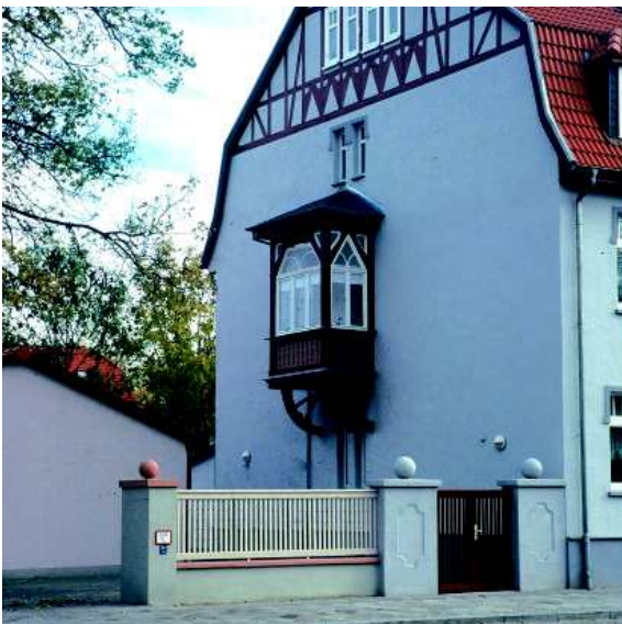
Abb. 178: Kleiner hölzerner Erker an der Giebelseite eines gründerzeitlichen Gebäudes.
