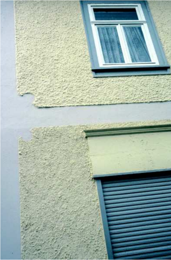
Abb. 35: Charakteristische Kombination von Knoten- und Glattputz zur Gliederung der Fassade
