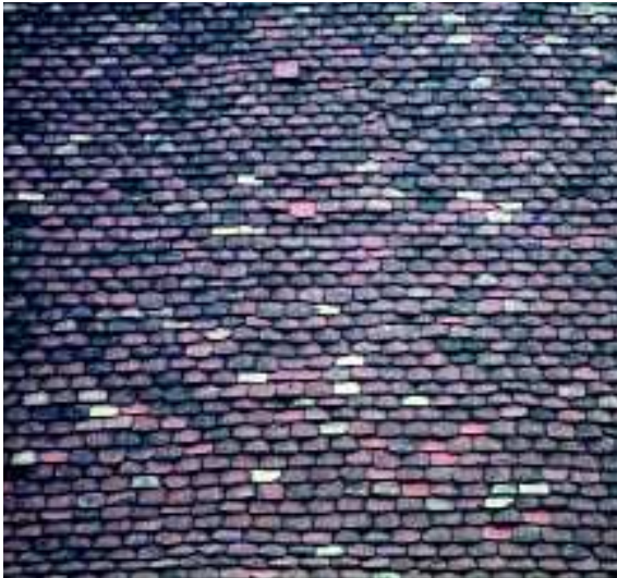
Abb. 64: Ton-Biber-Deckung
