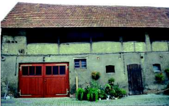
Abb. 177: Typisches Laubenganggebäude mit Lehmausfachung im originalen Zustand
