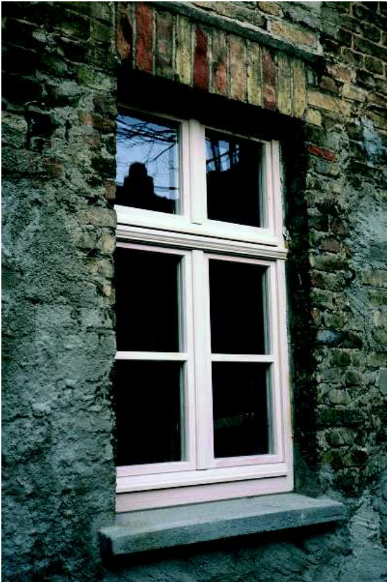
Abb. 104: Zum Vergleich ein positives Beispiel: 4-flügliges Holzfenster mit echten, glasteilenden Sprossen
