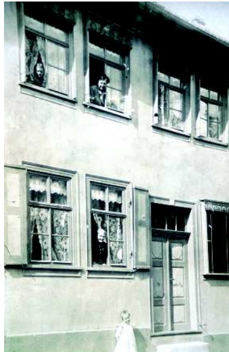
Abb. 89: In der historischen Aufnahme ist die achsiale Anordnung der Fenster gut zu erkennen. Die damals neuen Jalousiekästen aus Blech gehören heute bereits wieder der Vergangenheit an.
