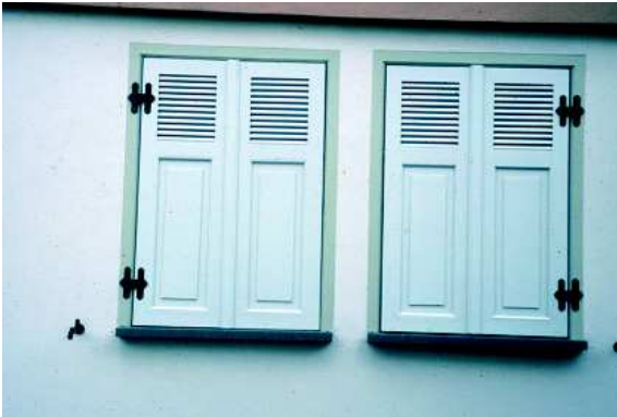
Abb. 131: Neue Fensterläden sind eine Bereicherung für die Fassade
