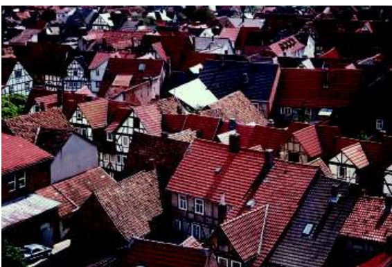
Abb. 41: Eine ruhige Dachlandschaft ohne Aufbauten, Einschnitte, Fenster, etc.
