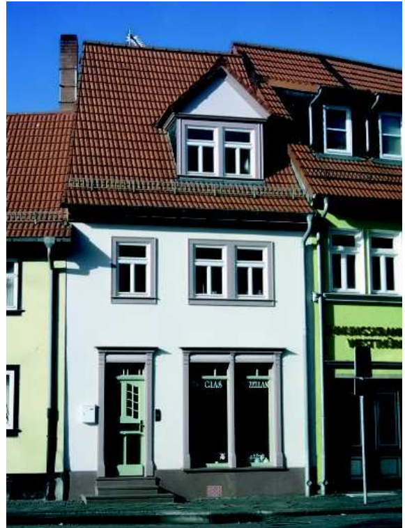
Abb. 93: ...und nach der Sanierung.
