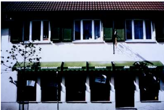
Abb. 167, 168: Schaufenster zerteilt die Fassade! Gebäude vor (oben), nach der Sanierung (unten). Die Schaufensterfläche ist nahezu unverändert.
