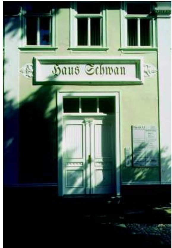
Abb. 154: ... in saniertem Zustand
