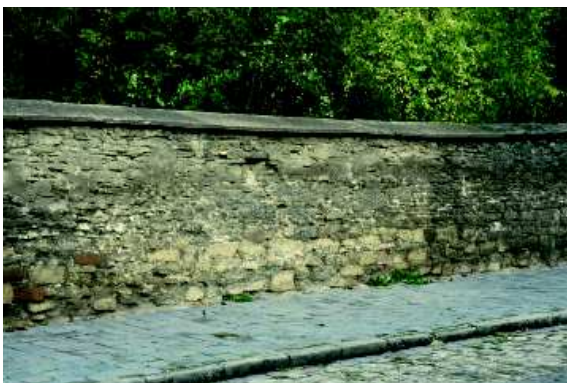
Abb. 212, 213: Raumbildung durch verputzte oder begrünte Mauer
