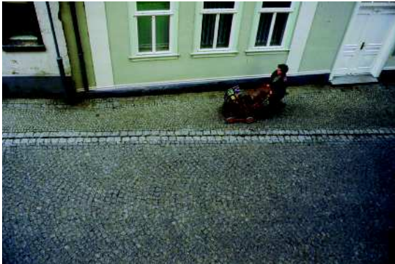
Abb. 203: Beispielhaft gestaltete neue Oberfläche.
