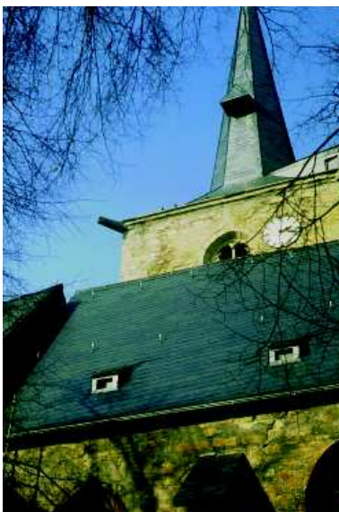
Abb. 5: ...die großen, prägenden Bauwerke ...
