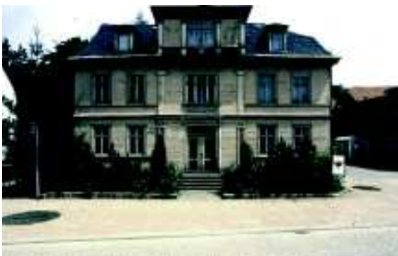
Abb. 176: Reichhaltige Gliederung der Putzfassade durch Gesimse, Pilaster und „Bossierung“
