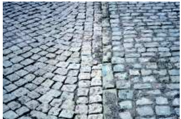
Abb. 205: Neues und altes Pflaster
