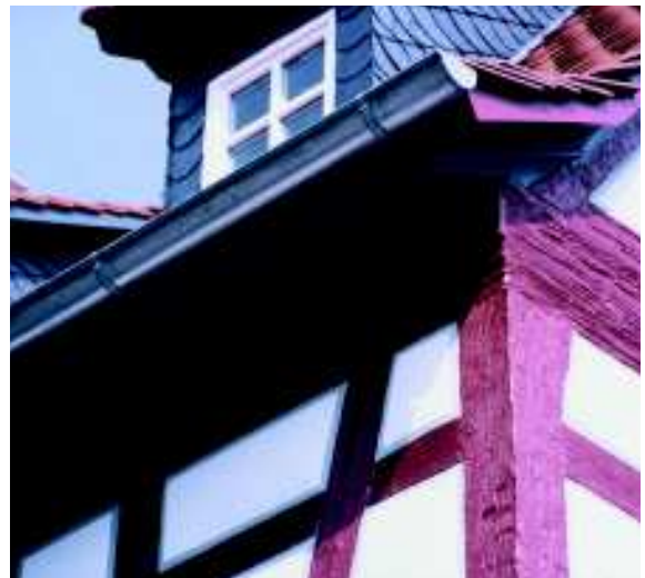
Abb. 78: Traufe und Ortgang m. sichtbaren Sparren
