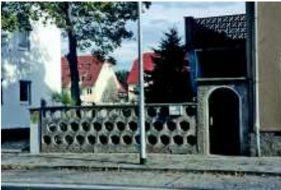
Abb. 215: Negatives Beispiel: Die Fertigteilmauer wirkt grob und bietet zudem wenig Schutz.
