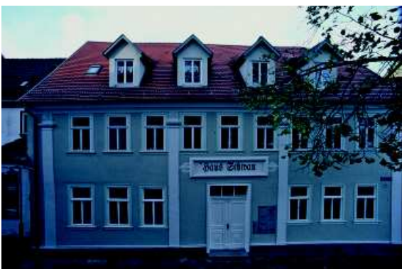
Abb. 30: Gelungenes Beispiel einer Sanierung. Hier wurden richtige Materialien stilgerecht verwendet.
