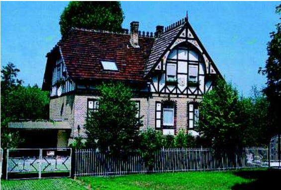
Abb. 69: Typisches Dach aus der Gründerzeit mit besonderen Firstziegeln.
