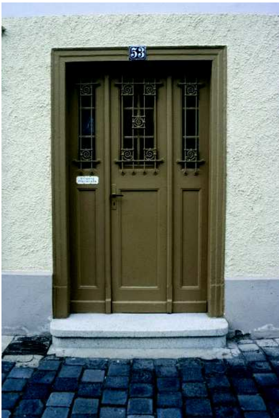
Abb. 150: Sehr schöne Sömmerdaer Eingangstür. Das Bild entstand nach der Instandsetzung.
