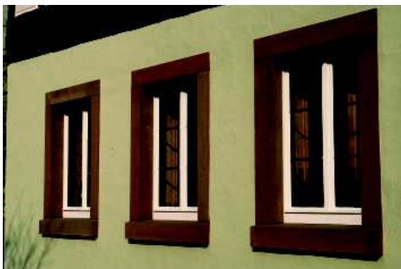
Abb. 127: Kastenfenster in einem Sandsteingewände
