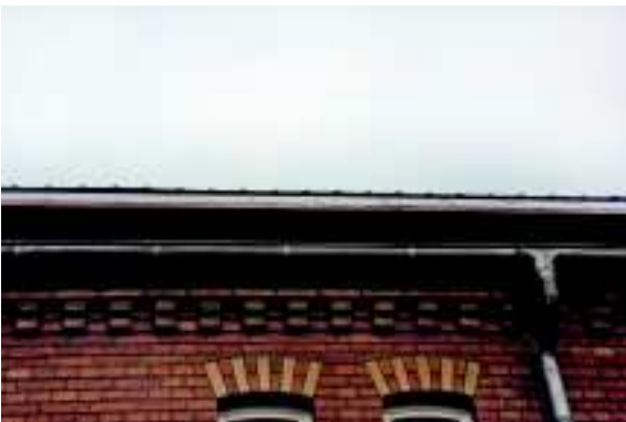
Abb. 82: Gemauertes Traufgesims an einem Backsteingebäude der Gründerzeit
