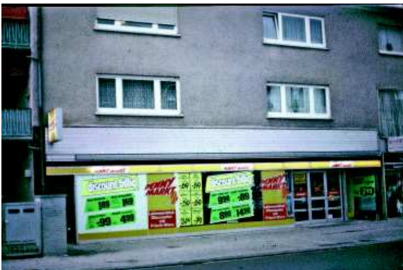
Abb. 196: Negatives Beispiel: Leuchtreklame und das Bekleben von Schaufenstern sind unzulässig
