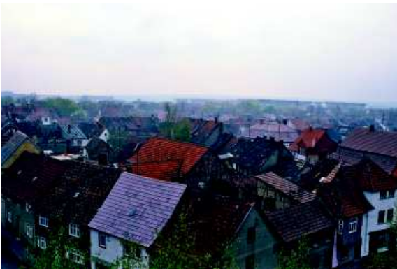
Abb. 62: Typische Sömmerdaer Dacheindeckung in Tonfalzziegeln
