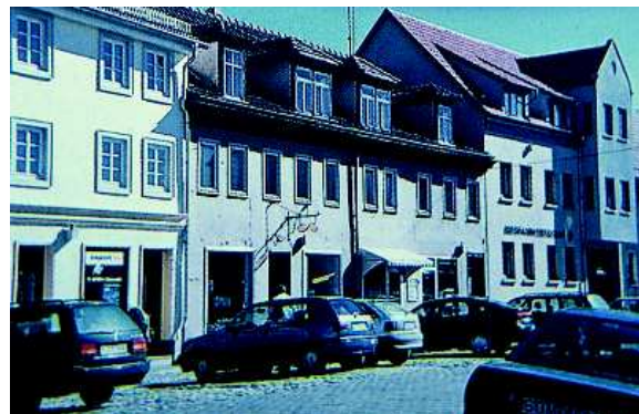
Abb. 23: Links saniertes Gebäude, rechts Neubau. Städtebaulich aufeinander abgestimmte Grundprinzipien führen zur harmonischen Gesamtwirkung.
