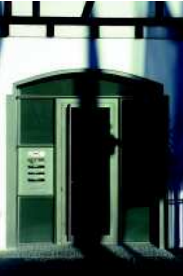
Abb. 161: Farbe, Gliederung, Briefkasten, Abstellfläche und Klingel – hier wurde an alles gedacht
