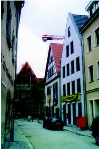
Abb. 109: Die neuen Fensterformate sind aus der historischen Form entwickelt.
