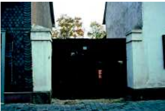
Abb. 217: Typisches Holzlattentor mit Mannpforte zwischen kräftigen Mauerpfeilern.
