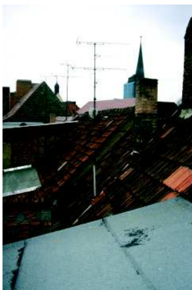
Abb. 71: Technische Anlagen stören die schöne, ruhige Wirkung des Dachs
