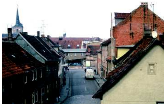
Abb. 42: Die ordnende Wirkung einheitlicher Dächer ist prägendes Element der Stadtansicht und der Straßenräume.
