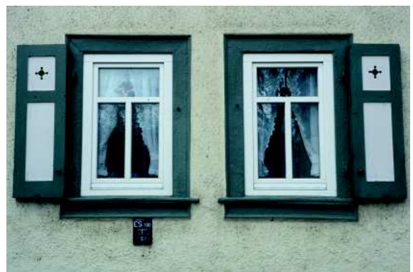
Abb. 137: Instandgesetzte Klappläden bereichern die Fassade.
