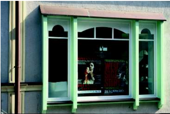
Abb. 195: Harmonische Ausbildung eines Schaufensterkastens
